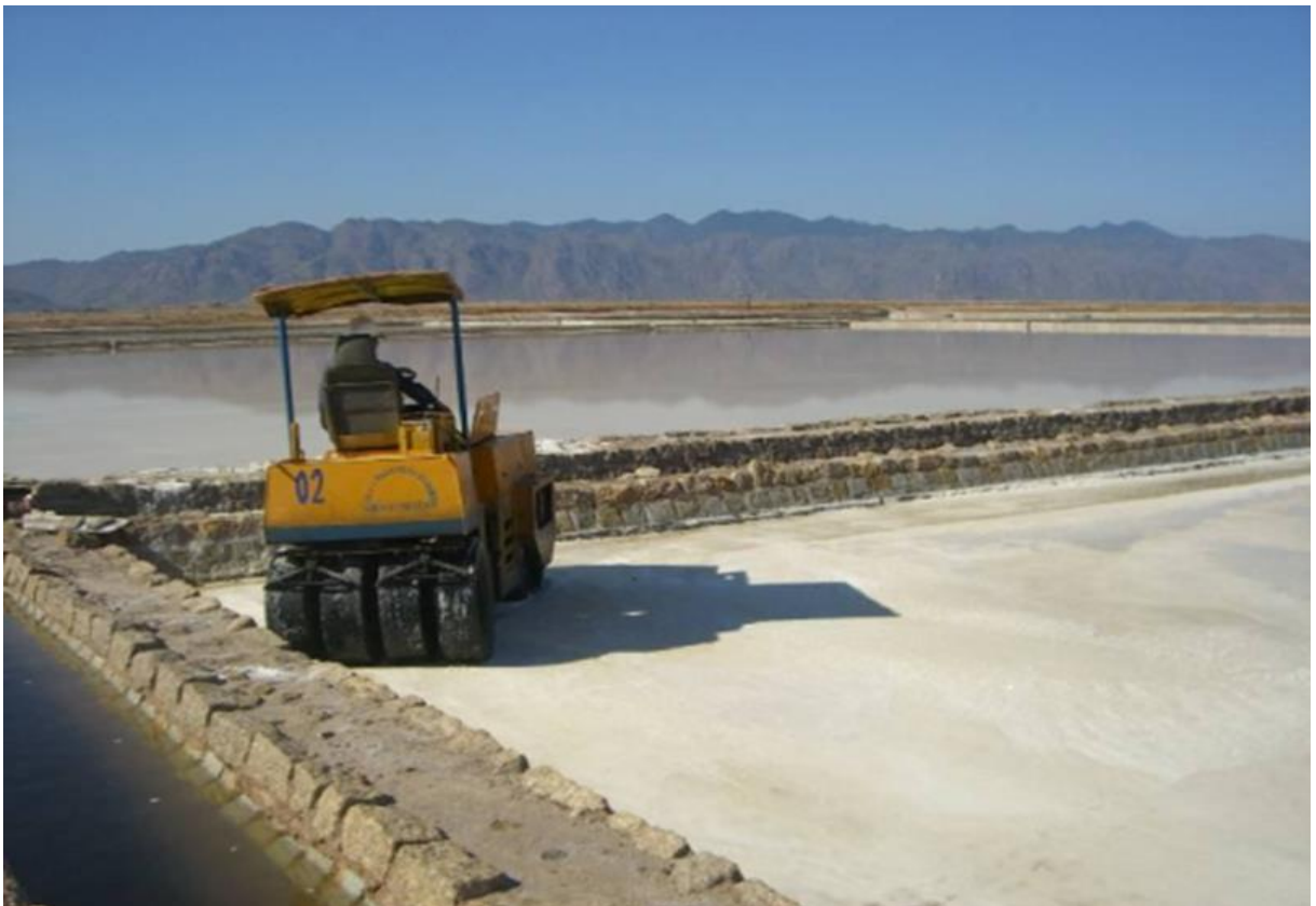
Hình 5. Lăn ép mặt ruộng muối
